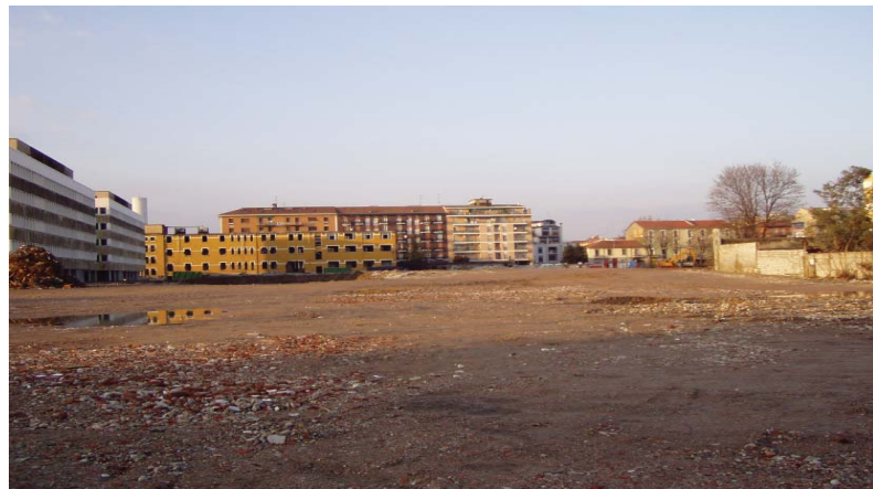
veduta del cantiere di via Grazioli
